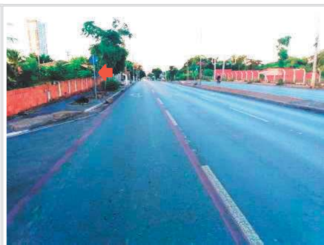
VISTA DA SITUAÇÃO PELA AVENIDA MIGUEL SUTIL
