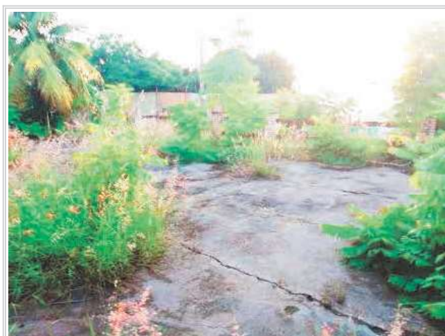
VISTA PARCIAL INTERNA / LOTE
